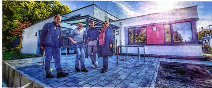
Lars Fischer, die Café-Spiegel Mitarbeiter Manuel Mian und Raphael Krause sowie Anna Pielken-Rieger (v. li.) stehen an der Rückseite des Neubaus der Goslarer Drogenberatung. Am 2. November wird das Gebäude offiziell eingeweiht. Foto: Roß
