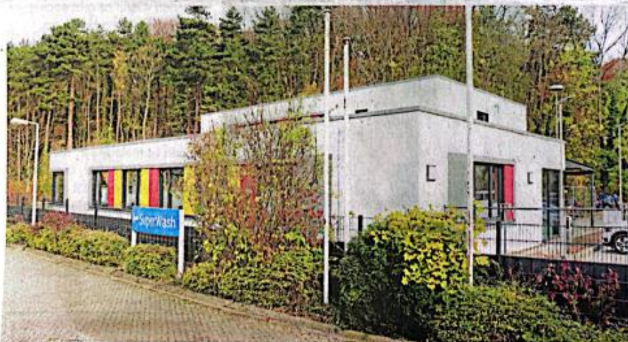
Die neue DROBS befindet sich auf dem Parkplatz hinter der Aral-Tankstelle Hildesheimer Straße. Planungszeit 2,5 Jahre, reine Bauzeit 15 Monate. Träger ist der Paritätische aus Braunschweig.
